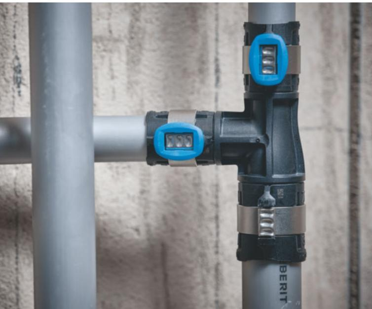
Ohne Verwechslungsgefahr: Dank farbiger Indikatoren an den FlowFit Fittings weiss der Installateur, welche Pressbacke zu verwenden ist.
