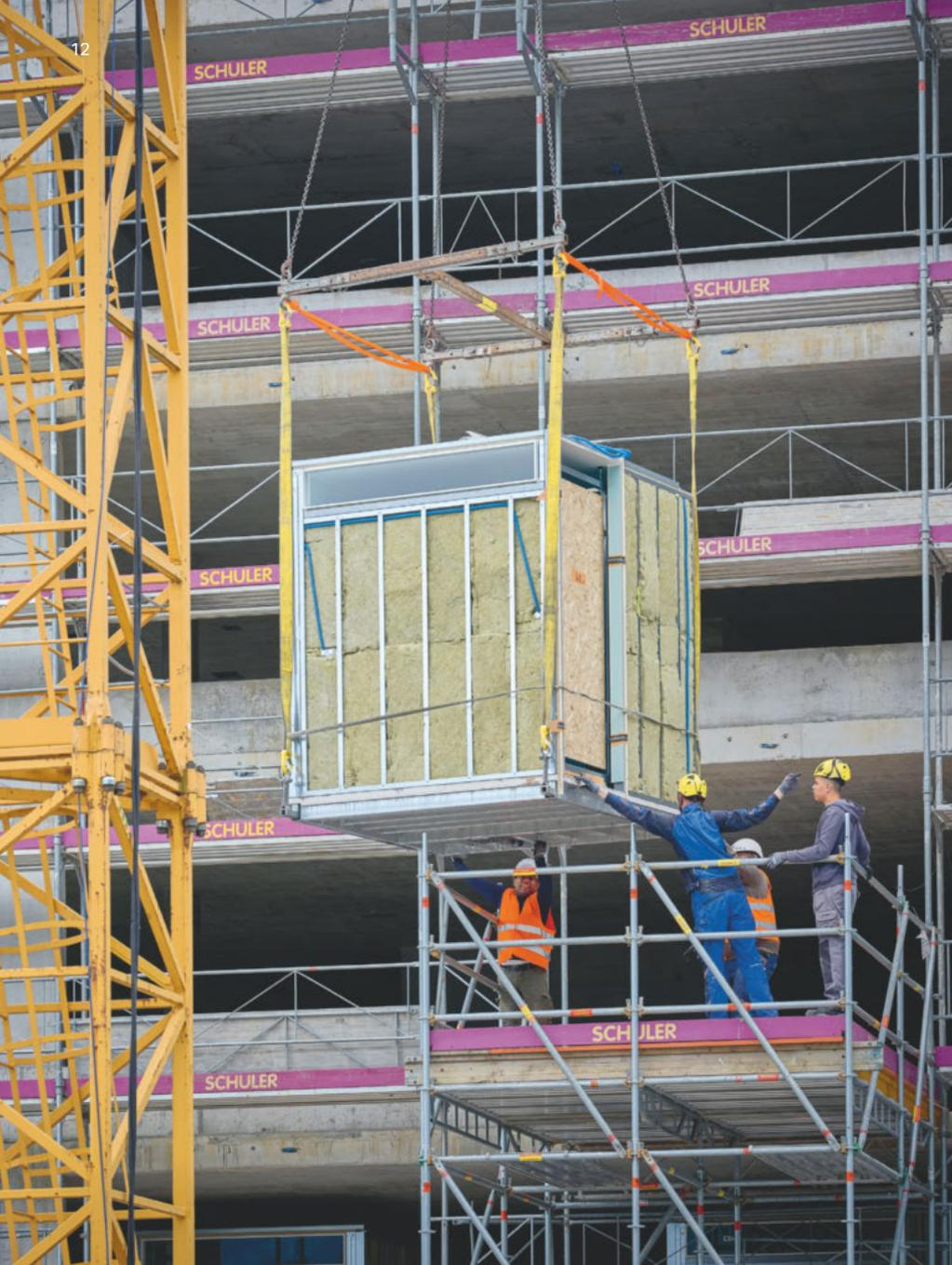
Innerhalb von zehn Minuten wird ein Fertigbad vom Sattelschlepper gehoben und ins Stockwerk eingebracht.
